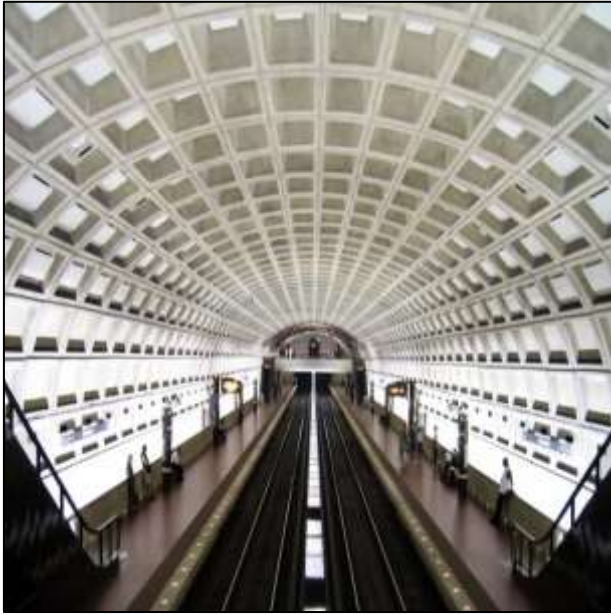
Fig. 1: Waffle Slab
