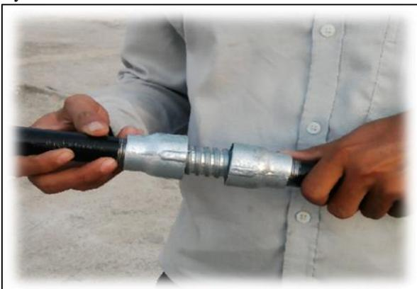
Fig. 3: Flexible Arrangement to Conduit
