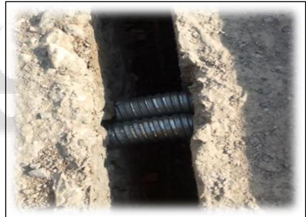
Fig. 13: Flexible Conduit at Block-2
