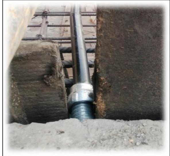
Fig. 12: Flexible Conduit Installation
